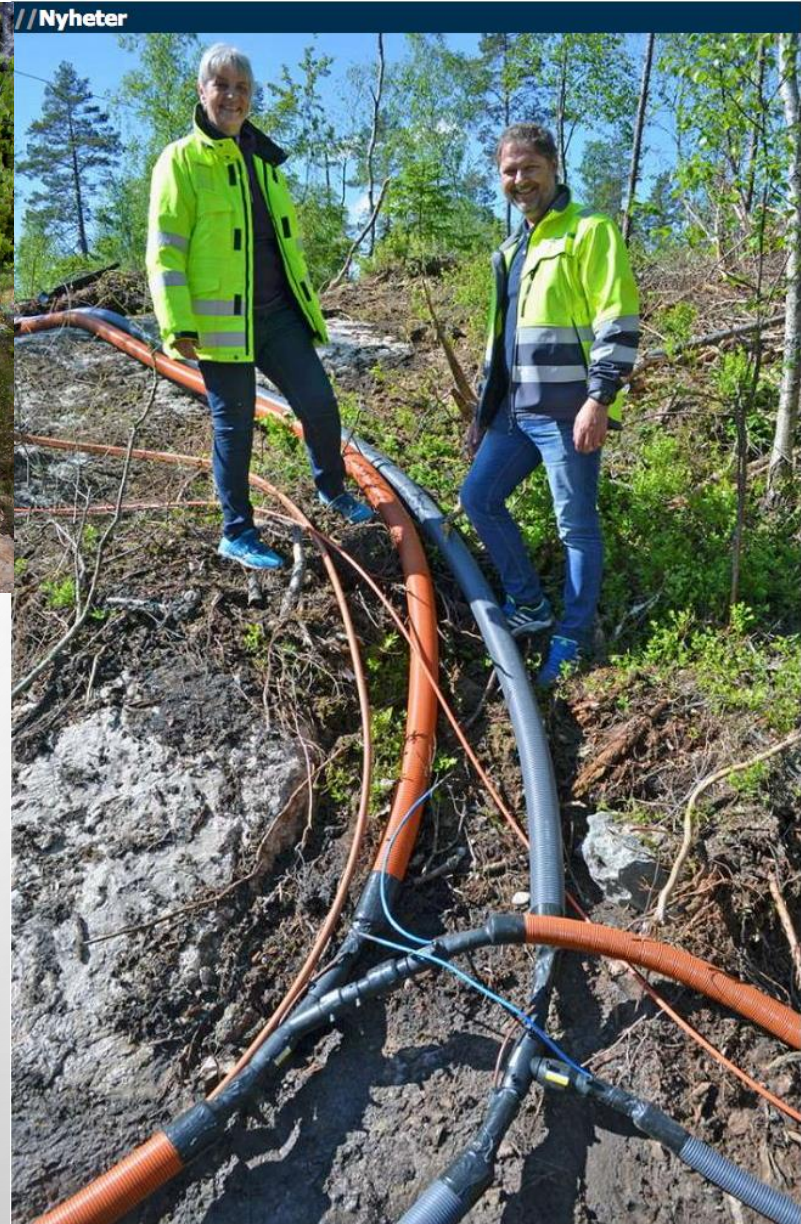
Vigdis Berg og Aksel Ruud fra Isoterm følger opp legging av frostfrie rør.
